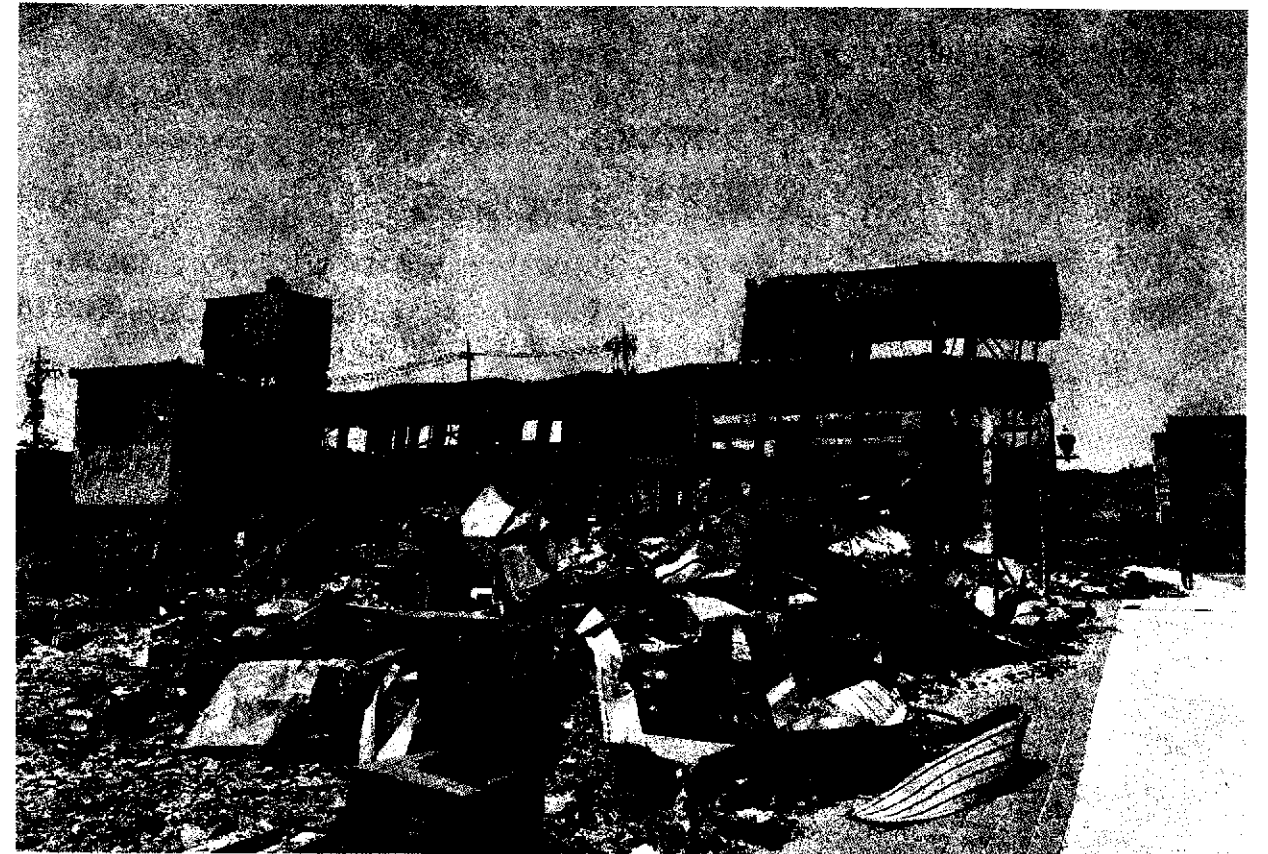
輪島市朝市通りの火災現場 むき出しになった鉄骨とコンクリートの残骸、まだ、ミシミシと音を立てています(撮影:立石雅昭)
